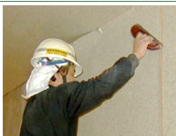
▲防火壁紙（布）之耐燃標示，僅顯示試驗基材以接著劑黏貼壁紙（布）後的耐燃等級變化，不能直接比照建築技術規則所稱的耐火板或耐燃材料。
