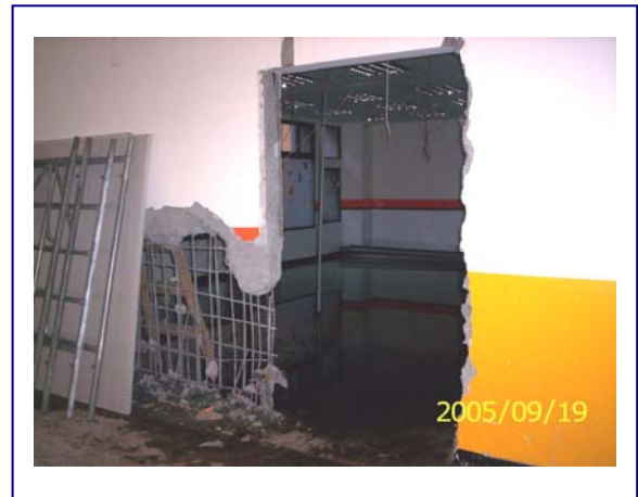
▲ 室內裝修涉及分間牆之變更、增加或減少，涉及公共安全時應經開業建築師檢討並簽證負責。
