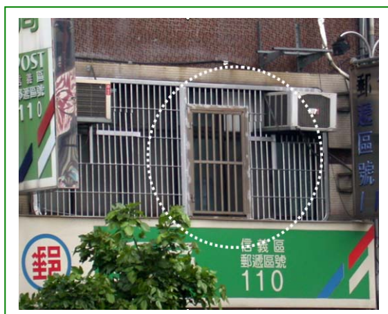
▲ 公寓大廈住戶設置鐵窗，應留設供消防人員救災使用之有效開口（高度 120 公分、寬度 75 公分以上）。違者，得通報主管建築機關依違章建築查處。
