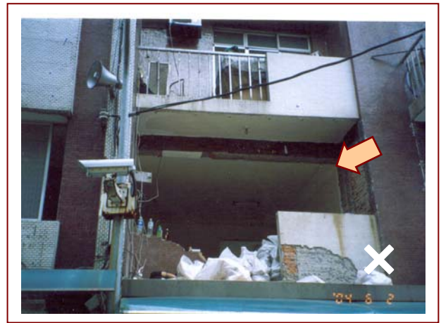
▲ 擅自拆除外牆，將「陽台外推」已涉及違章建築行為。
