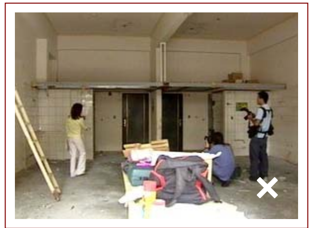
▲ 擅自拆除外牆，將「陽台外推」已涉及違章建築行為。
