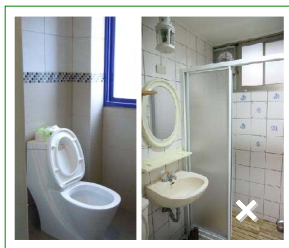
▲ 集合住宅隔成多間套房者，無論是否有「既存違建」，其原核准陽台範圍內，均不得設置廁所或浴室使用。
