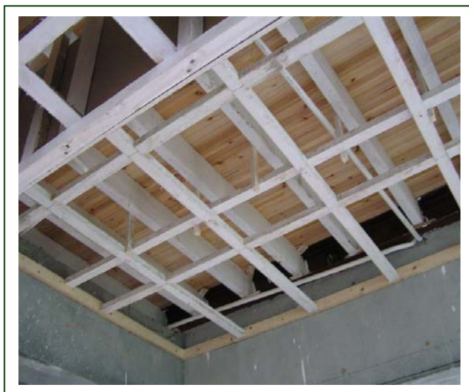
▲ 天花板木質托架表面刷塗防火漆施工案例
