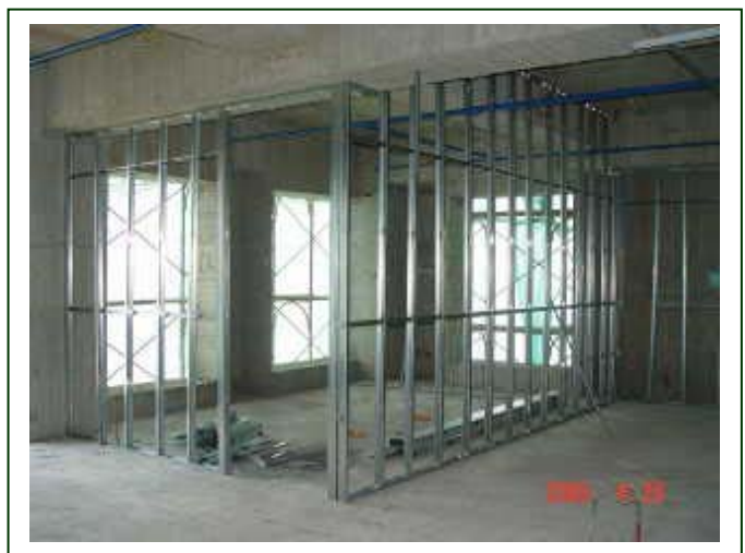
▲ 輕鋼架隔間牆具有良好的防火、防潮、耐撞擊力、耐震性，隔音效果佳。（施工中案例）
