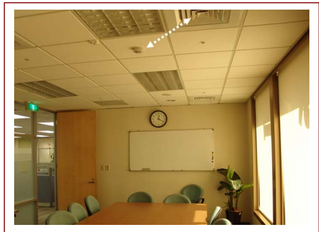
▲ 火警探測器之裝設位置錯誤案例（距離空調出風口至少應達 1.5 公尺以上）
