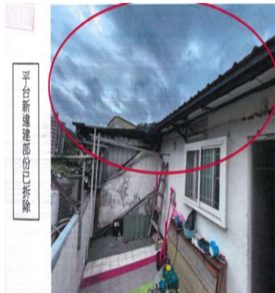
【案例】新違建部分拆除
