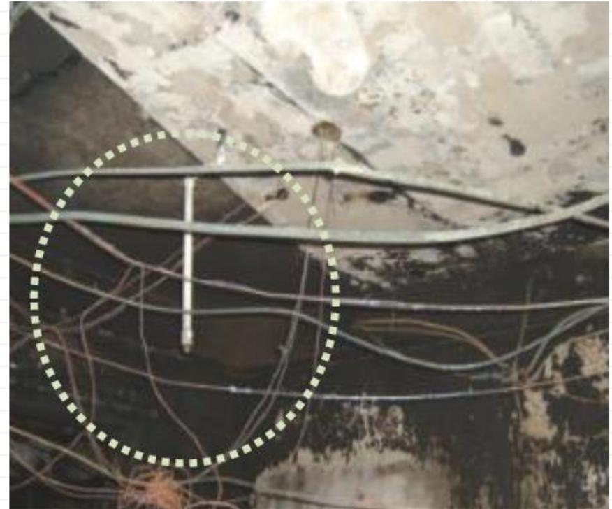
室內裝修施工過程擅自剪斷火警警報系統並封閉灑水頭致災。
