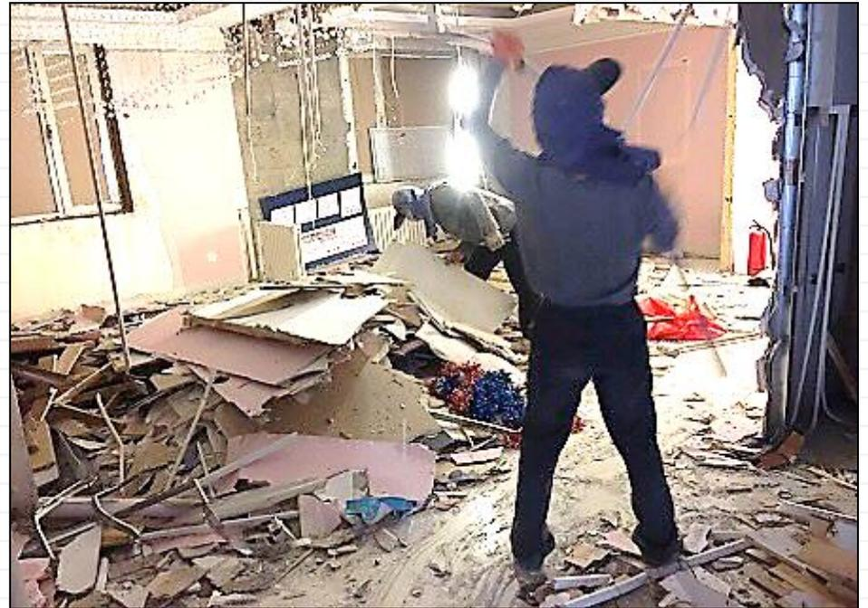
營業場所違規以易燃板材隔間裝修，經主管建築機關強制拆除。
